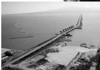
▲諫早湾の潮受け堤防と排水門
